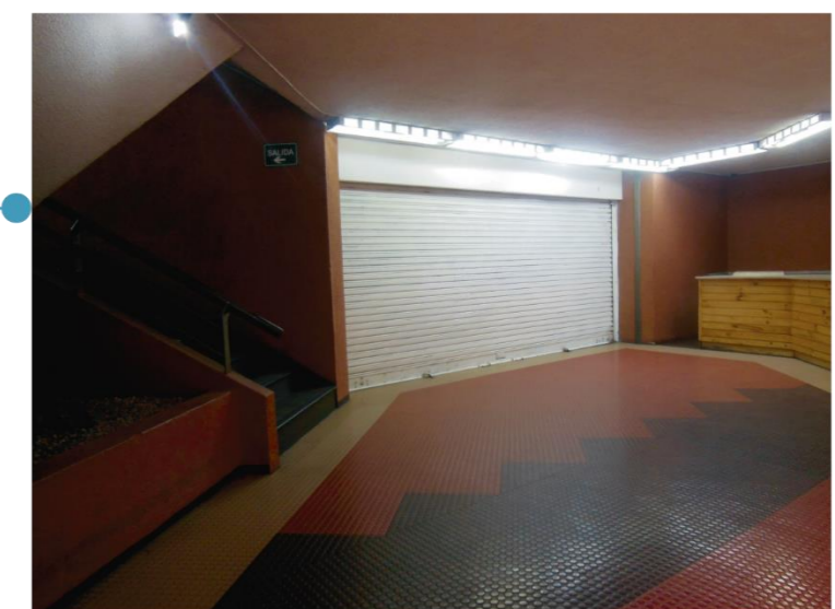
Ingreso y local comercial del Patio de Comidas en desuso
