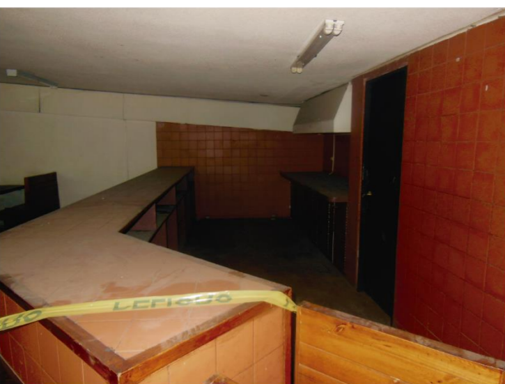
Cocina del Patio de Comidas en desuso
