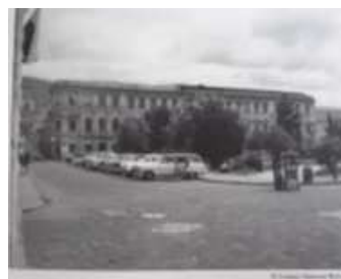
Antes del terremoto Imagen N° 2 Fuente: Paredes, 2010
