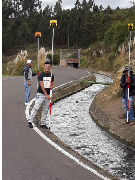
Levantamiento topográfico ejecutada con estación total trimble M3
