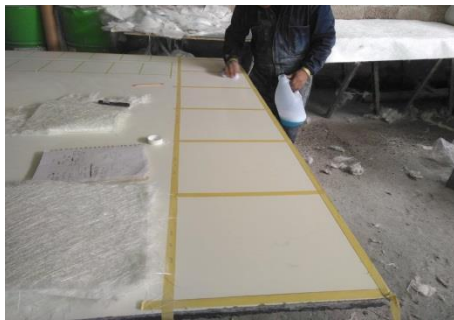
Figura 3.4 Aplicación del desmoldante [Autor]
