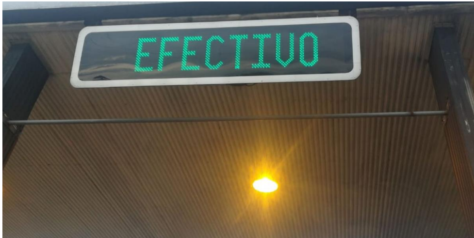
Fig. 6.74. Control de encendido y apagado de marquesina
