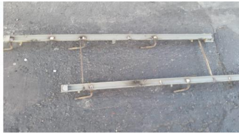
Fig. 6.22. Soldadura de bases de sensores clasificadores
