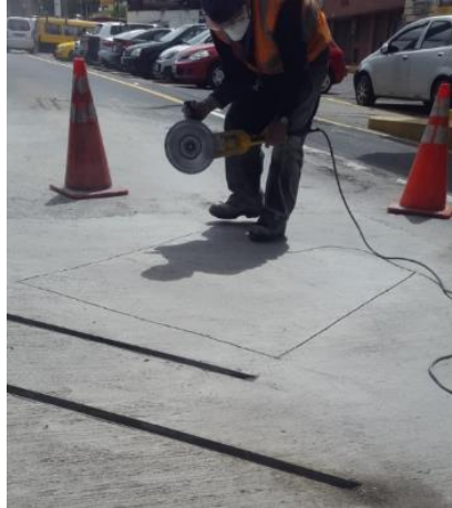
Fig. 6.20. Corte de concreto para colocación de bobina loop de piso.
