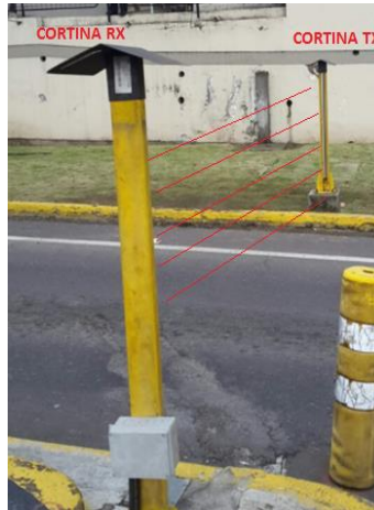
Fig. 6.3. Ubicación de sensores ópticos tipo cortina.
