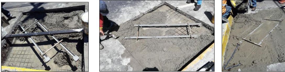
Fig. 6.18. Colocación de sensores en estructura de hormigón.
