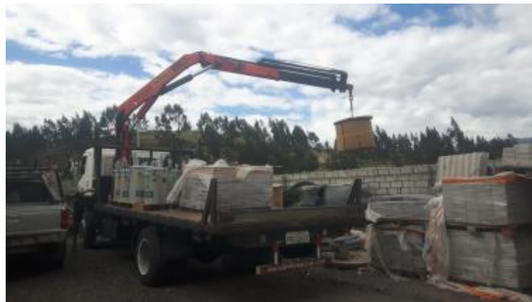
Fig. 43. Grúa e Izaje Fuente: El Investigador
