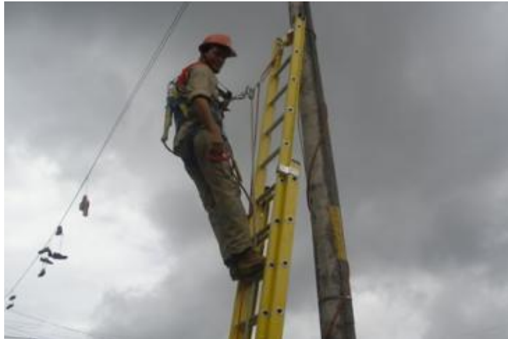
Fig. 32. Trabajos en altura con apoyo de escalera Fuente: https://bit.ly/2Ry161C
