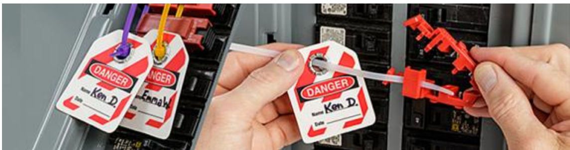
Fig. 48. Retiro de Bloqueos, finalizando el trabajo Fuente: https://bit.ly/2RCNvJM
