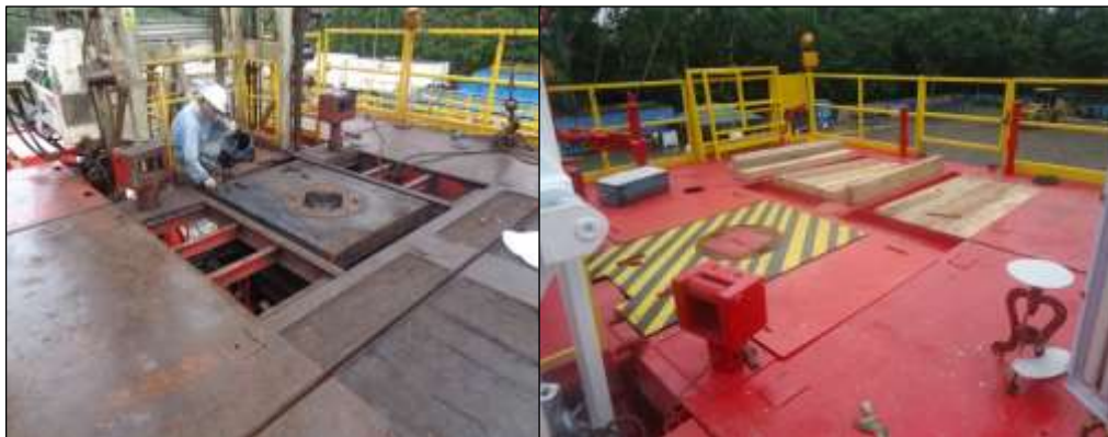
Imagen 33: Cambio de piso de la mesa del Rig
