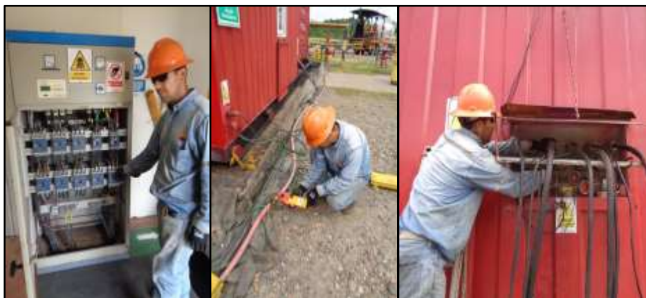
Imagen 12: Electricista – Inspección del sistema eléctrico
