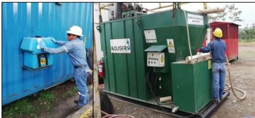
Imagen 18: Campamentero – Limpieza de lavajoes y planta de aguas residuales
