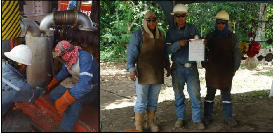
Imagen 13: Soldador – Construcción de protección para aislar partes calientes
