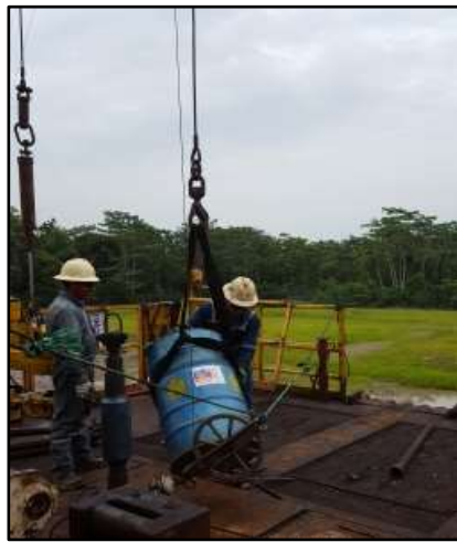
Imagen 1: Acción subestándar Izaje inseguro, mal uso de fajas
