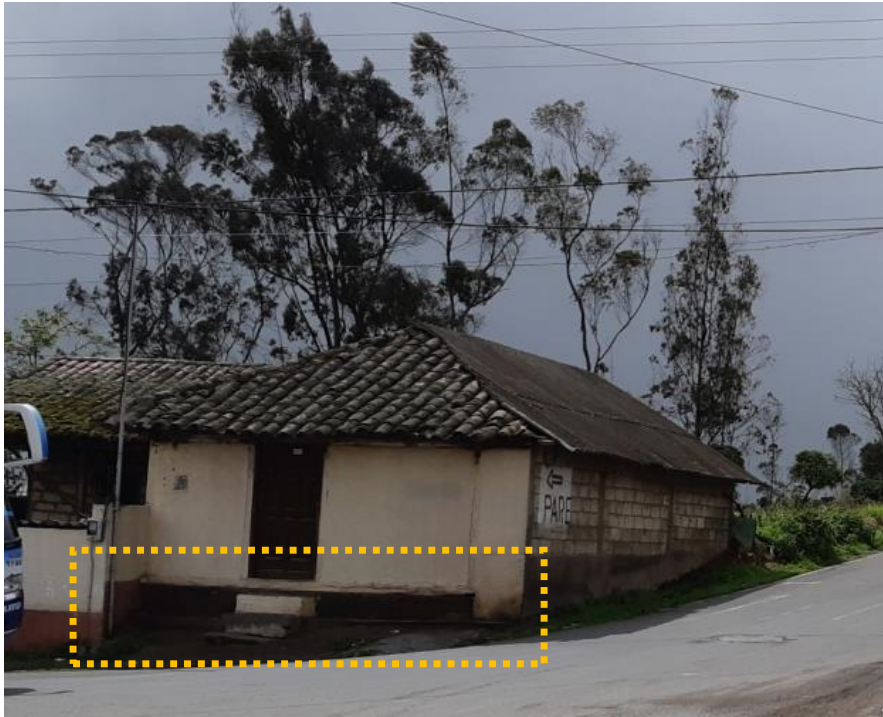
Fotografía 8. Construcción de cama de aire o aislamiento de vivienda del suelo, vivienda tradicional, ubicada en Huambaló – Segovia Autor: Aldás, J (2018)
