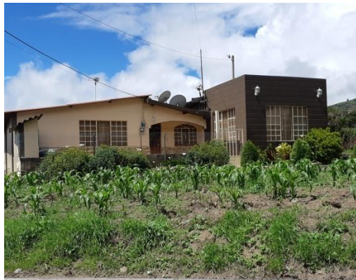
Fotografía 19. Sector Huambaló Centro Autor: Aldás J. (2018)
