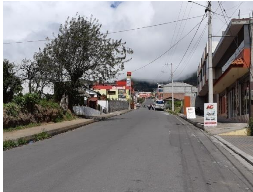
Fotografía 1. Sector Huambaló centro Autor: Aldás J. (2018)
