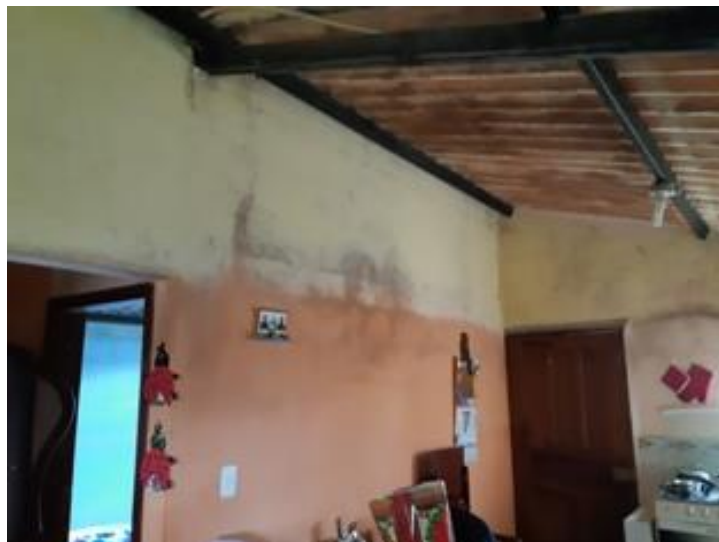
Fotografía 11. Vivienda Social, Huambaló – Centro /vivienda de estudio Autor: Aldás, J (2018)
