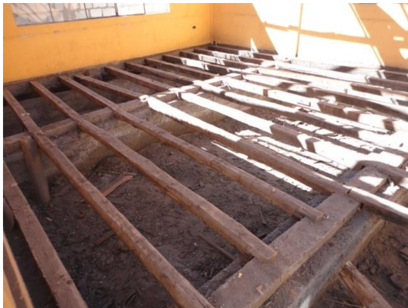
Fotografía 9. Edificación con sistema tradicional de construcción, actualmente derrocada – anterior casa parroquial El Rosario – Pelielo, sistema constructivo del contra piso. Autor: Córdova Marcos (2016)
