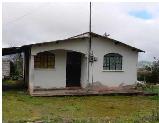
Fotografía 13. Sector Huambaló centro Autor: Aldás J. (2018)
