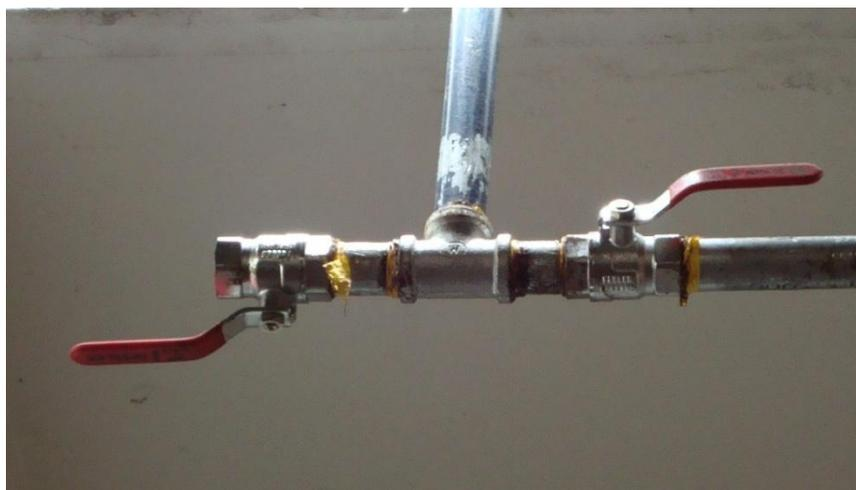
Figura N° 35. Seccionamiento de circuitos
