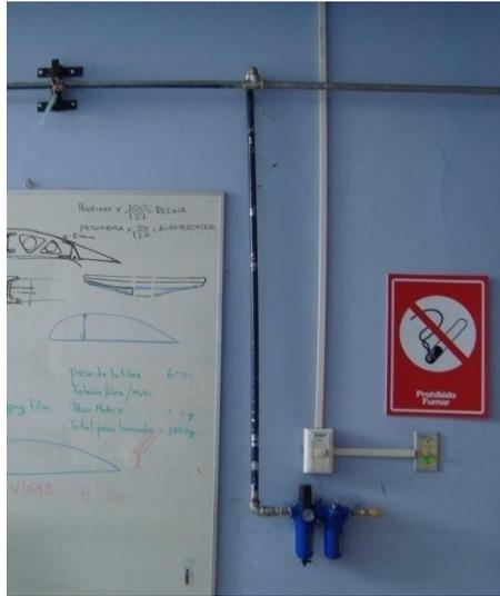
Figura N° 38. Regulador, filtro, lubricador instalado en el taller de materiales compuestos
