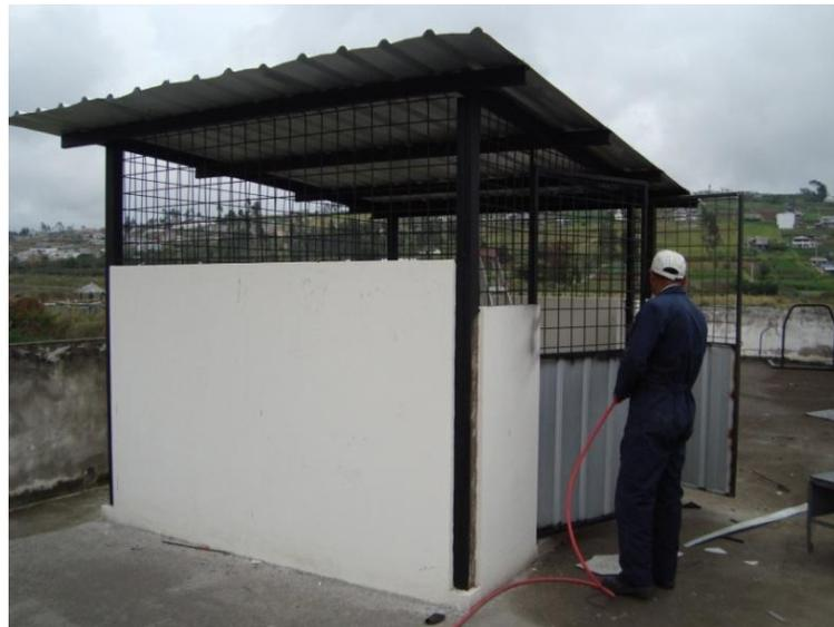
Figura N° 27. Estructura de alojamiento para el compresor en fase de acabados
