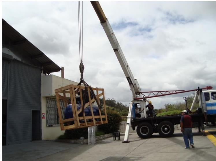
Figura N° 29. Elevación del compresor a su sitio de instalación
