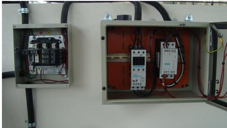
Figura N° 31. Sistema de arranque y de protección contra sobrecargas
