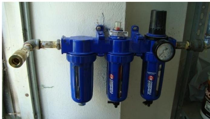
Figura N° 37. Regulador, filtro, deshumidificador, secador instalado en el taller de acabados
