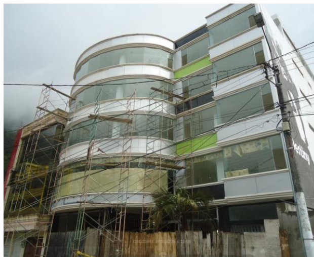
Fig. 6.22 Foto actualizada del progreso de la construcción
