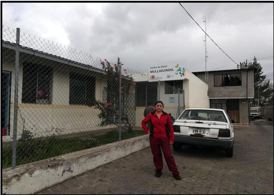
Exteriores del Centro de Salud Mulliquindil Santa Ana
