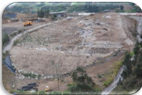
CELDA DE RESIDUOS COMUNES
