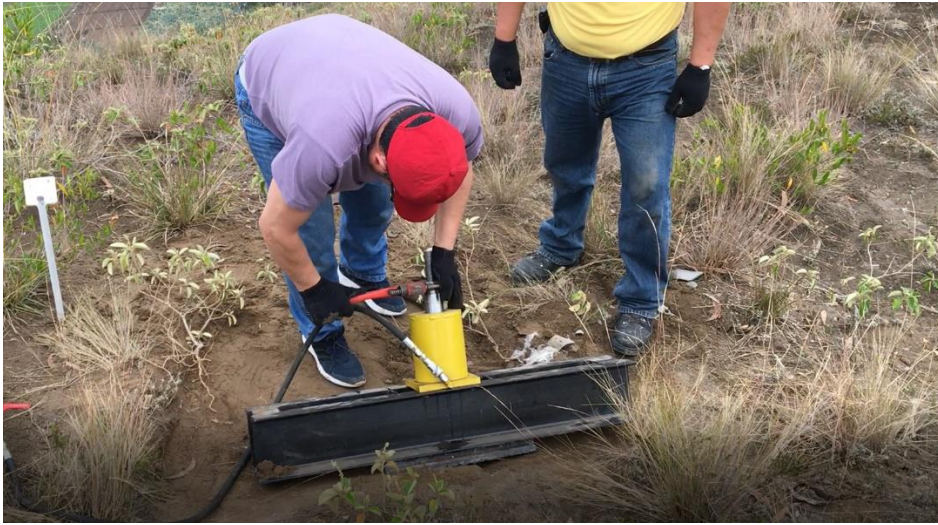
Figura 39 Alineación del equipo con el anclaje.
