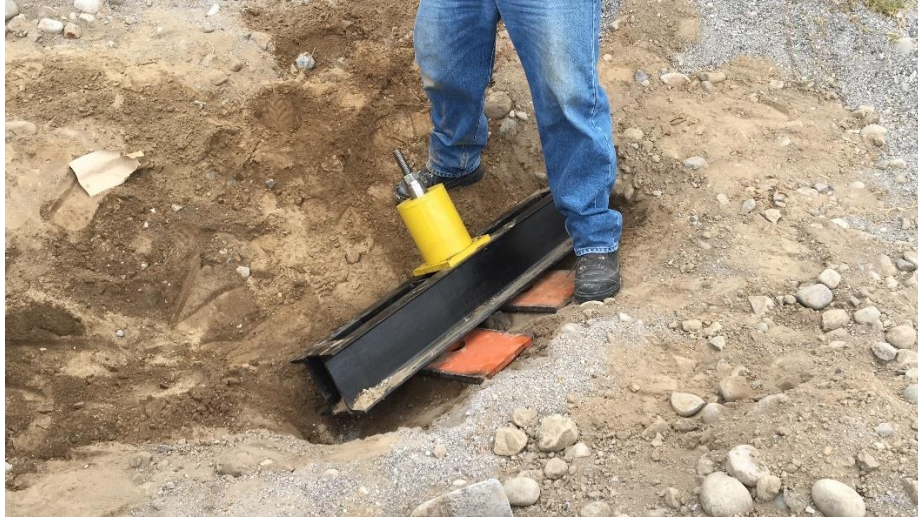
Ensayo con placas de soporte, colocadas una al lado de la otra en banco de pruebas.
