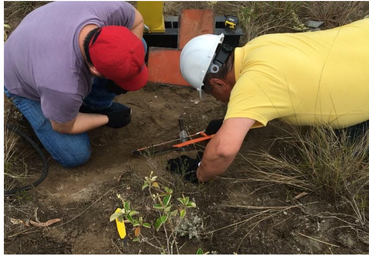
Figura 31 Corte de la barra de anclaje
