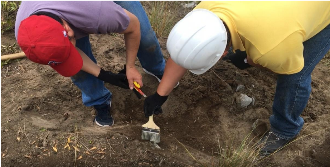
Figura 33 Limpieza de la rosca del anclaje.
