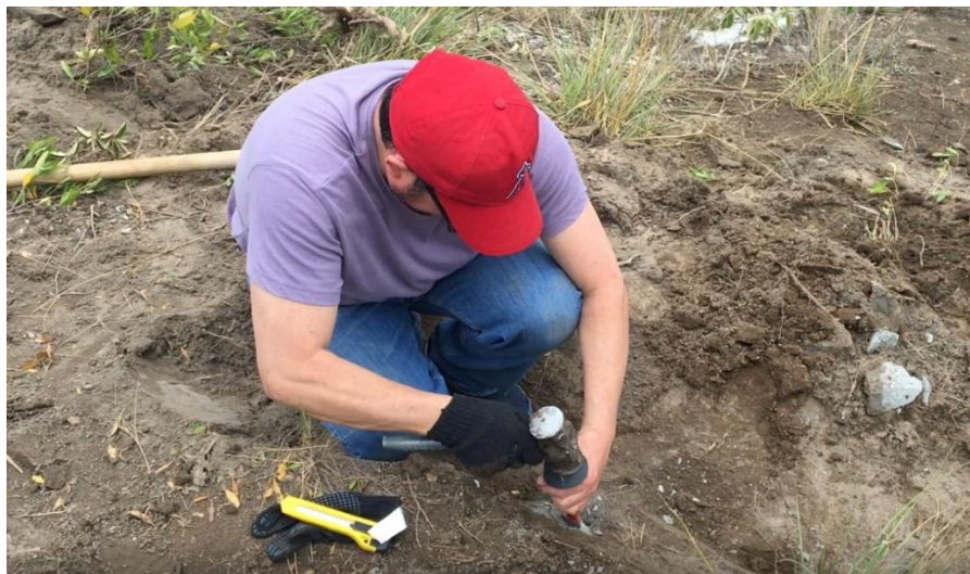
Figura 32 Retiro de restos de lechada del anclaje
