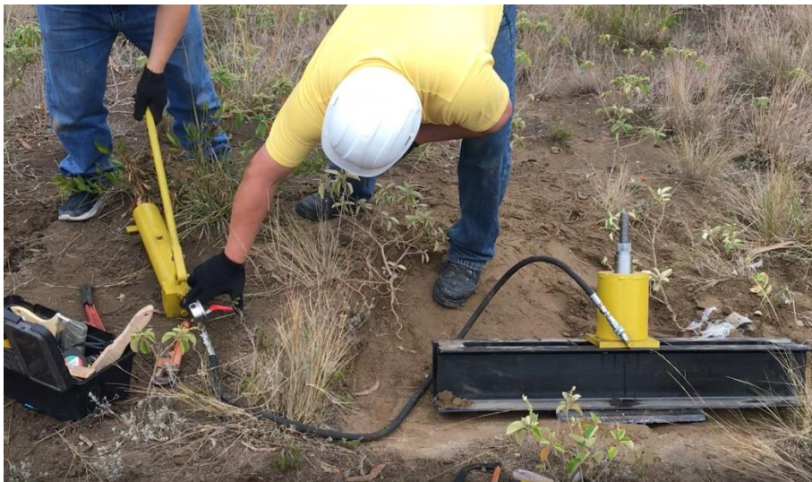
Figura 40 Abriendo la llave de paso
