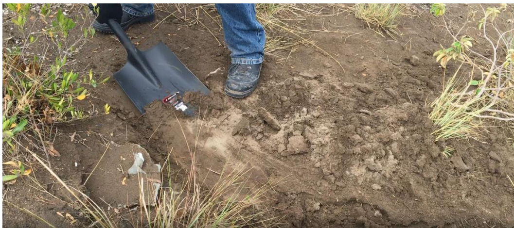
Figura 30 Perfilar la superficie de apoyo del equipo
