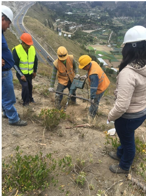
Perforación del agujero del anclaje
