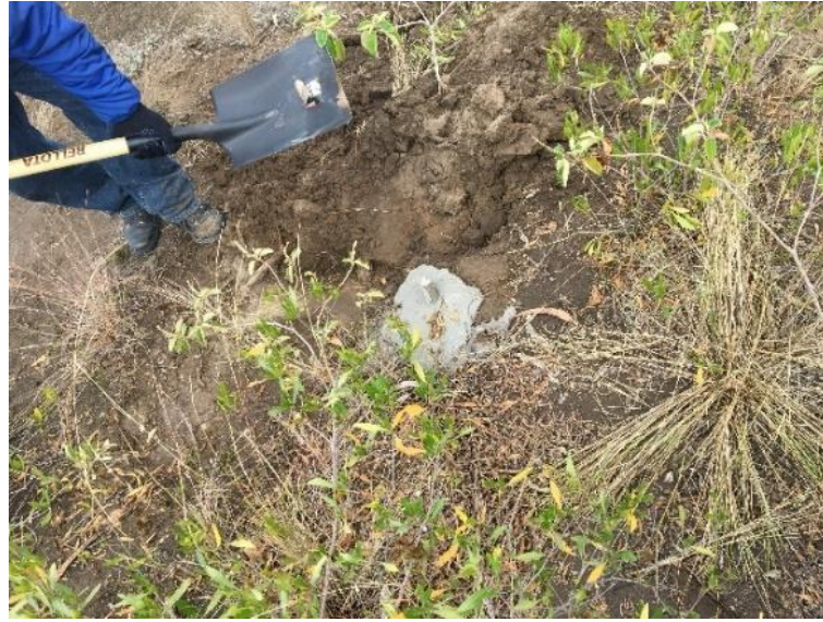
Figura 29 Desbroce del área de ensayo.
