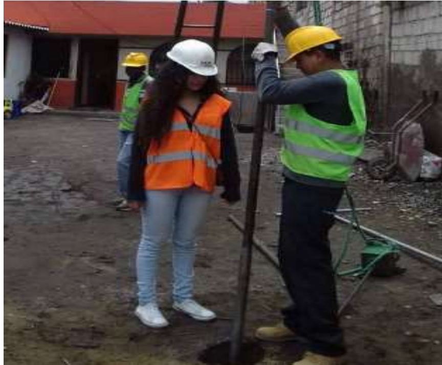
Fotografía 3. Extracción de la cuchara partida.
