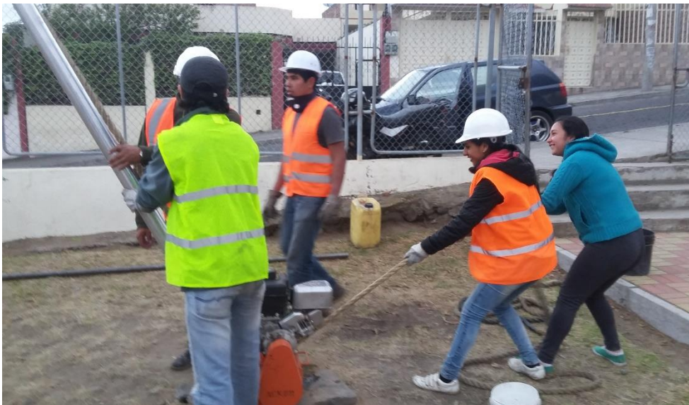
Fotografía 6. Realizando ensayo de penetración estándar (SPT)
