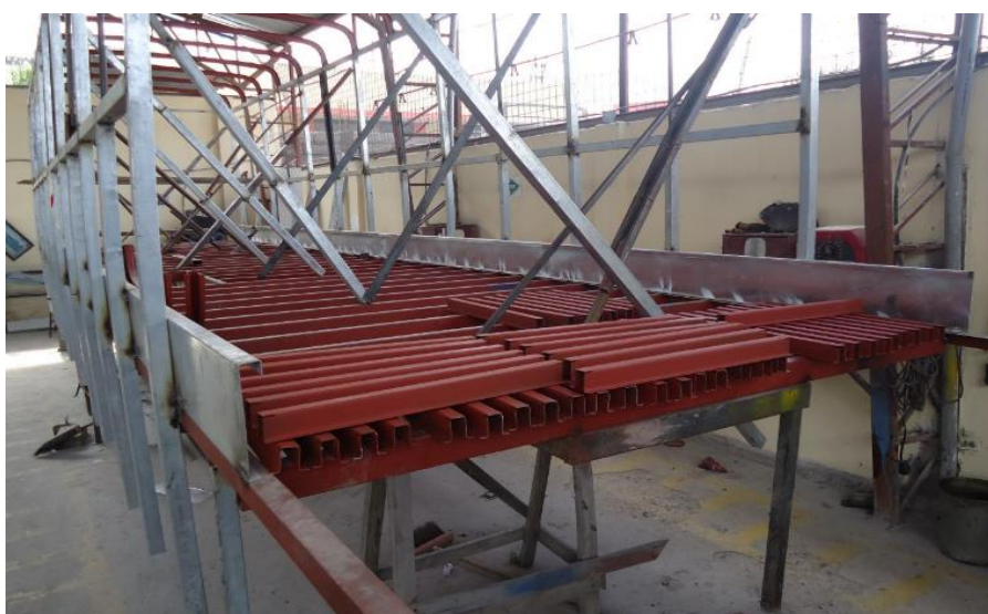
Fig. 11 Área de armado de estructuras
