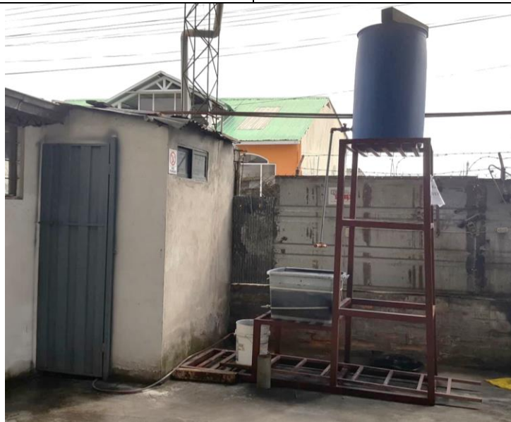
Estructura del Filtro
