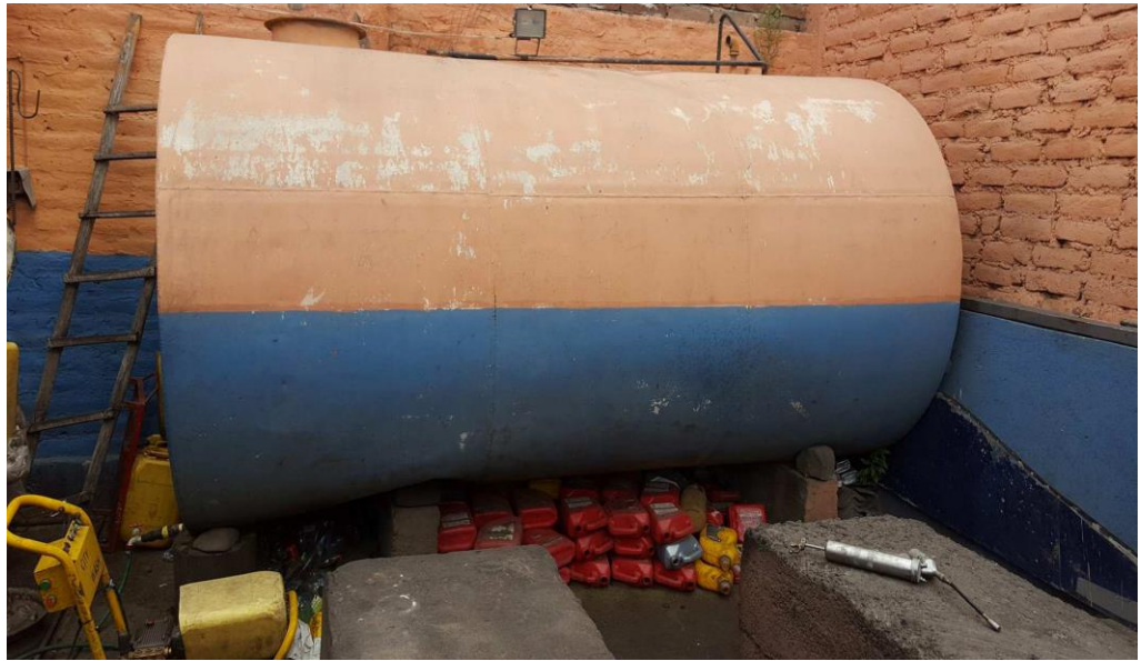
Tanque de almacenamiento de agua
