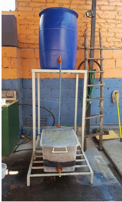
Instalación del filtro
