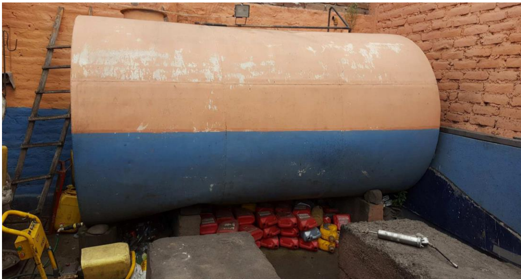
Imagen 3. Tanque de almacenamiento de agua
