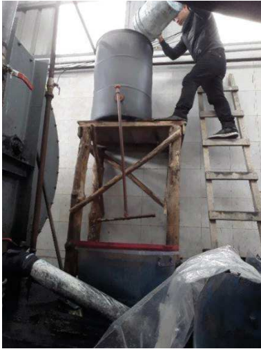
Llenado del tanque
