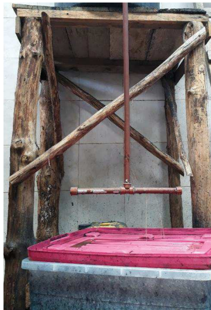
Imagen 7. Estructura para soporte del tanque
