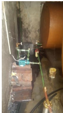
Figura 3-6: Bomba Centrífuga 2HP.
