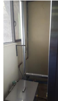
Figura 3-13: Línea de destrucción de vapor – esterilización.
