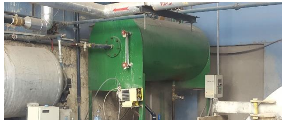
Figura 3-10: Sistema de ablandamiento del agua.
