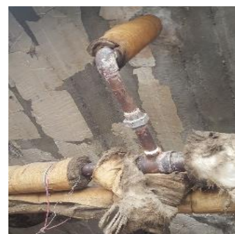
Figura 3-12: Línea de destrucción de vapor – lavandería.
