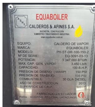
Figura 3-4: Placa de información de caldera de vapor pirotubular.
