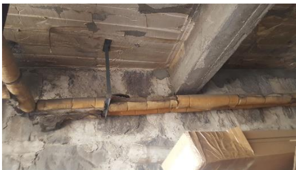
Figura 3-12: Línea de destrucción de vapor – lavandería.
