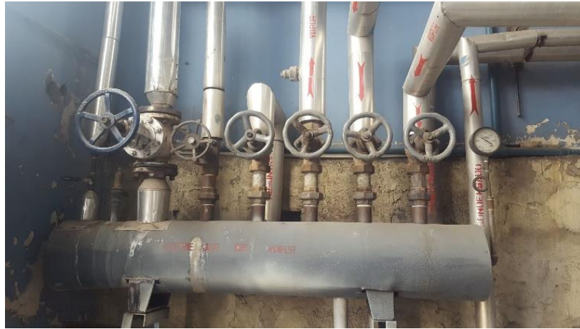
Figura 3-11: Sistema de distribución de vapor.
