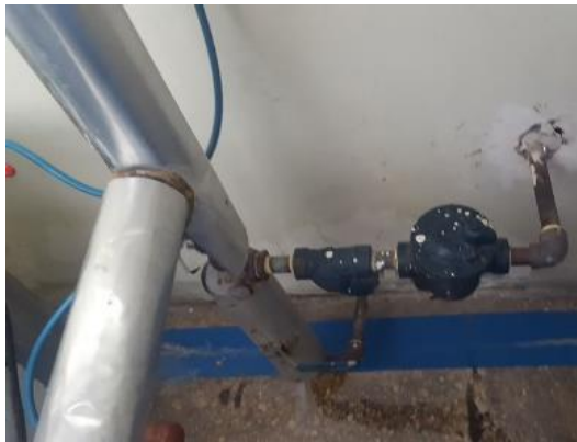
Figura 3-13: Línea de destrucción de vapor – esterilización.
