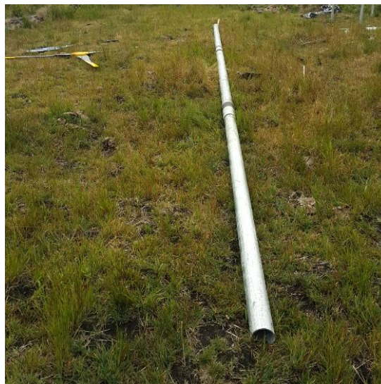
Armado de la torre en cuatro secciones
