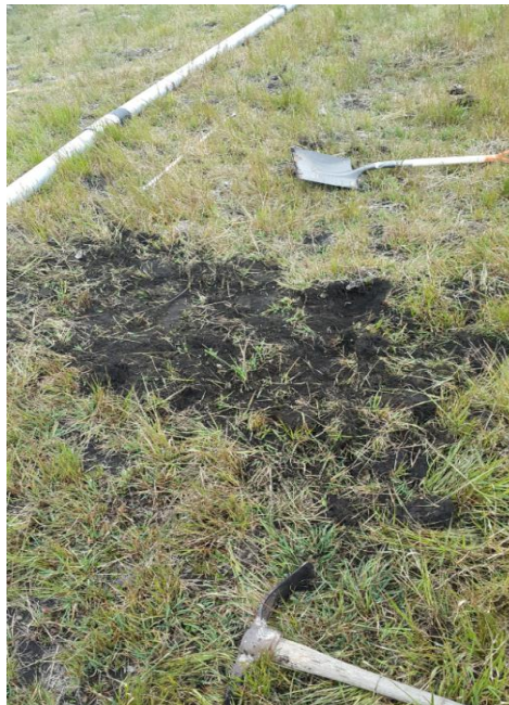
Excavación para implantación de la torre
