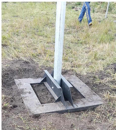
Base de la torre en el mecanismo de anclaje
