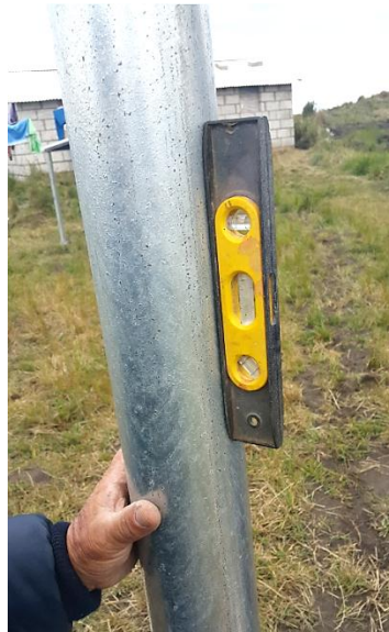
Nivelación de la torre
