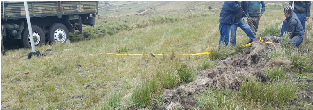
Colocación de los cables tensores
