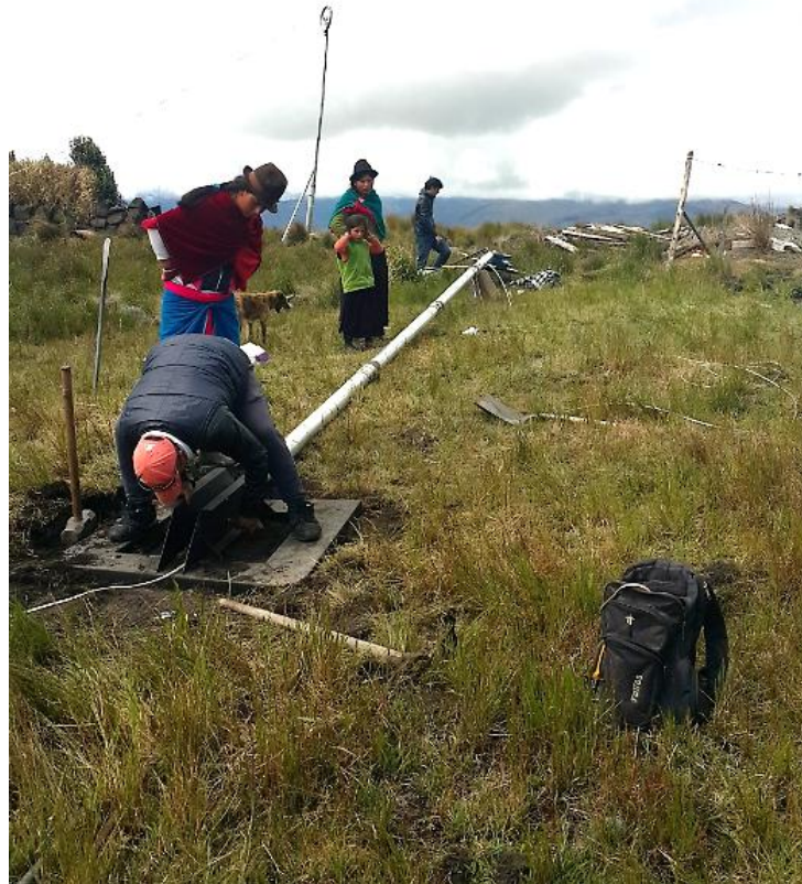
Levantamiento del aerogenerador mediante una grúa
