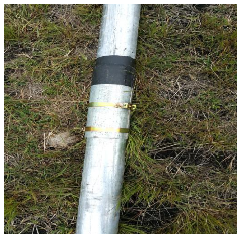
Sujeción de las secciones de la torre con abrazaderas
