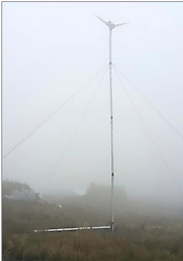
Fig. 45 Torre levantada con el sistema de contrapeso.
