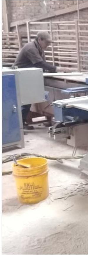
Operario masillando los tabloncillos
