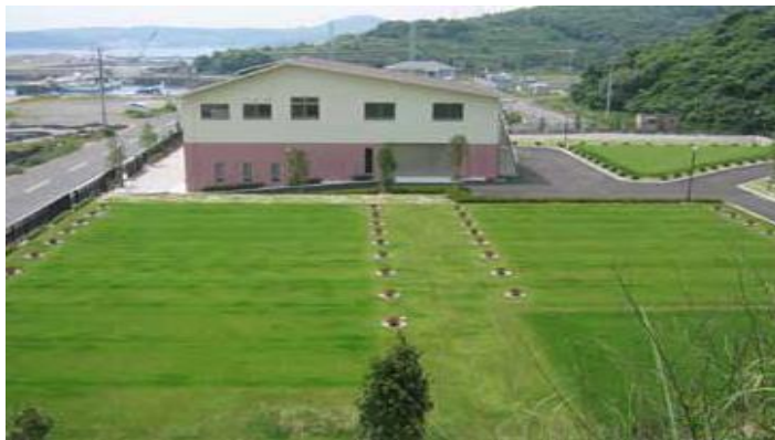
Imagen N° 2. Sistema de tratamiento Doyoo Yookasoo de aguas residuales.
