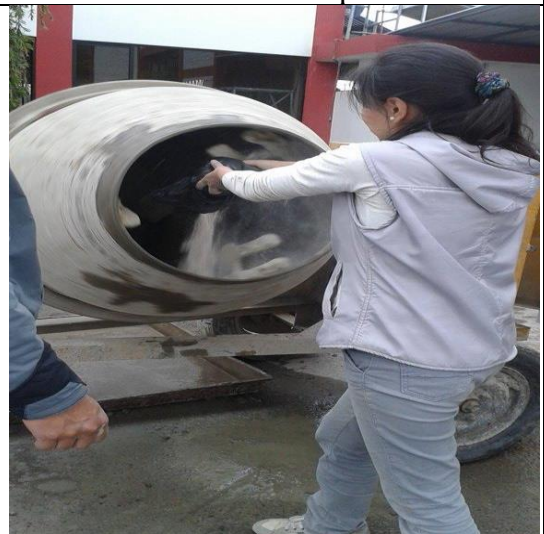
Adición de Cal
