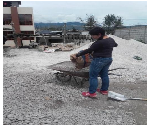
Adición del cemento a los agregados
