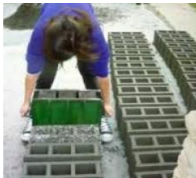
Fuente: Cantv.net Fabricación de mampuestos para la construcción.
