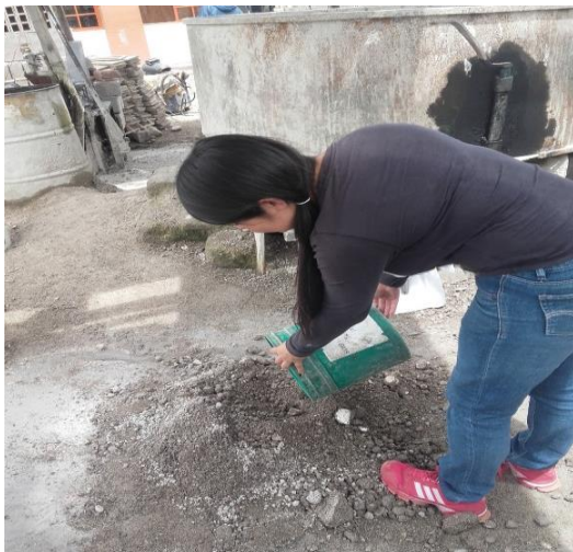
Adición del agua en la mezcla
