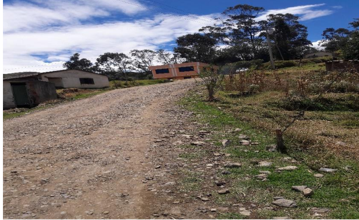
Fotografía N°1. Estado Actual de la Vía
