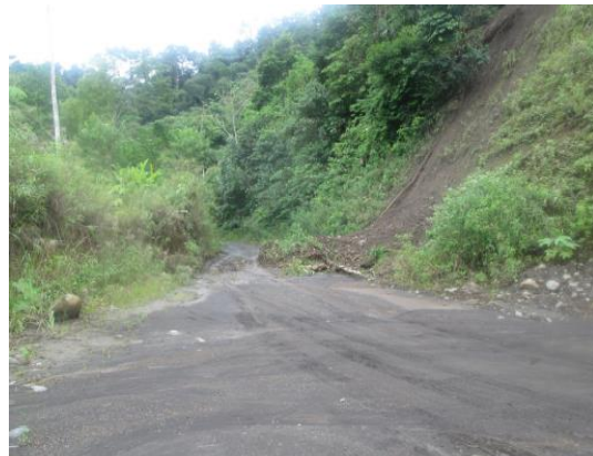
Foto N° 6.- Deslizamiento del Talud
