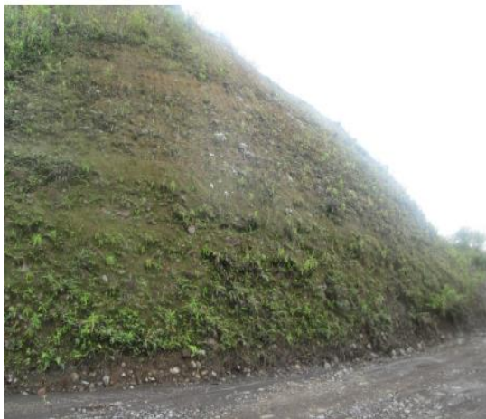
Foto N° 7.- Talud del Lugar
