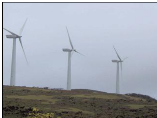
Fig. 1.4 Parque eólico San Cristóbal [4]
