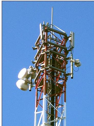
**Figura 6.18.** Imagen en la que se puede observar los brazos que sujetan el equipo de radio y antena.
