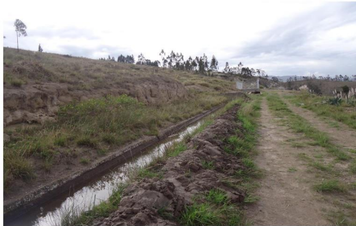
CANAL DE RIEGO AMBATO – HUACHI - PELILEO
