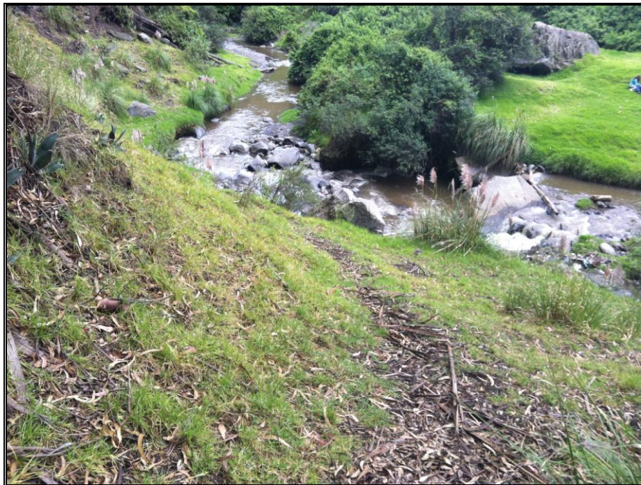
Margen Izquierdo (aguas abajo)
