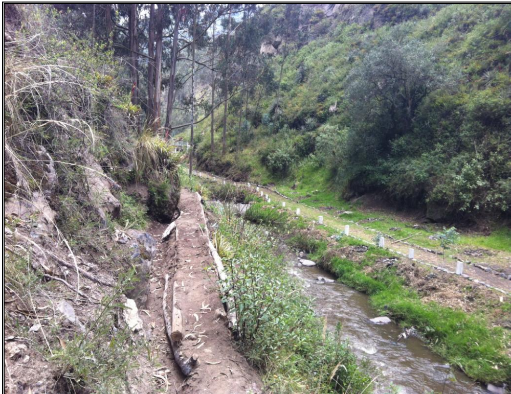
Margen Izquierdo (aguas abajo)
