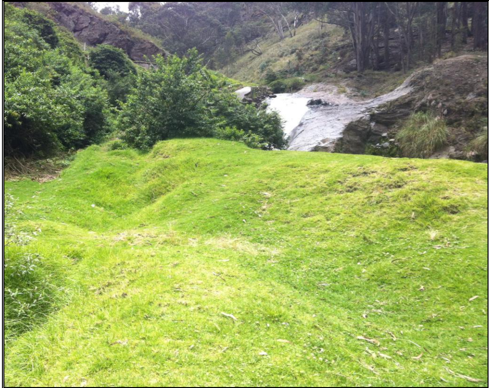
Margen derecho (aguas abajo)
