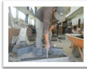
Grafico 5: Compactación del hormigón.
