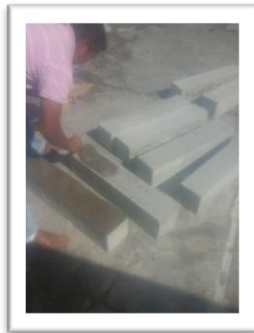
Grafico 9: Proceso de imprimación de la viga .
