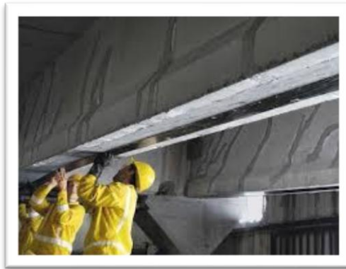
Figura 2: Aplicación de la fibra de carbono en una viga.
