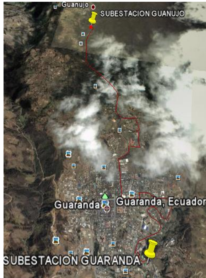
Figura 6.20. Ruta del tendido de fibra óptica para la unión de las subestaciones de Guanujo y Guaranda.
