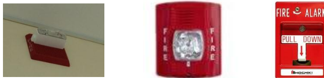
Figura N° 6.41: Sirena con luz estroboscópica y pulsador manual Fuente: Investigación de campo
