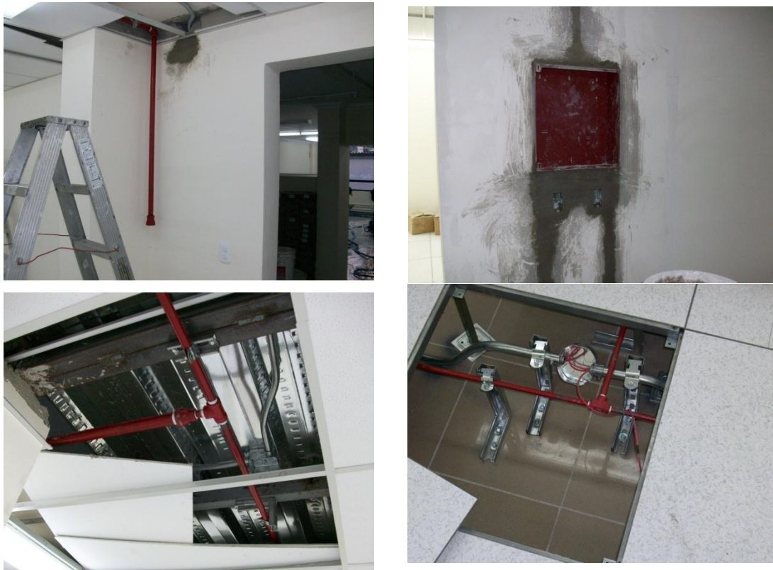
Figura N° 6.42: Instalación de una central de incendios Fuente: Investigación de campo
