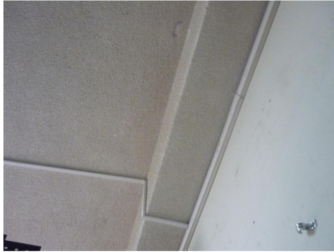
Figura N° 6.13: Techo del área Elaborado por: Diana Córdova Fuente: Investigación de campo
