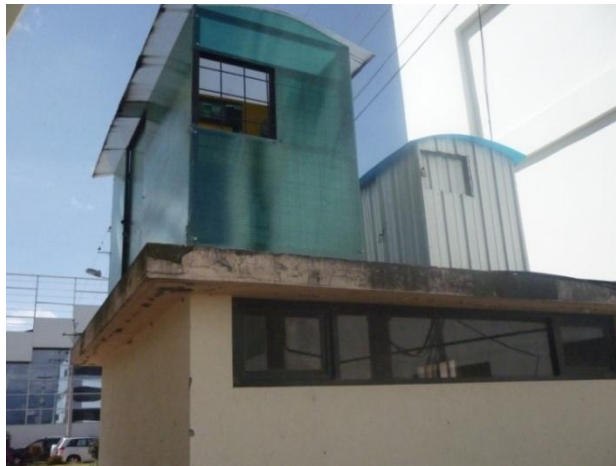
Figura N° 6.24: Generadores eléctricos Elaborado por: Diana Córdova Fuente: Investigación de campo
