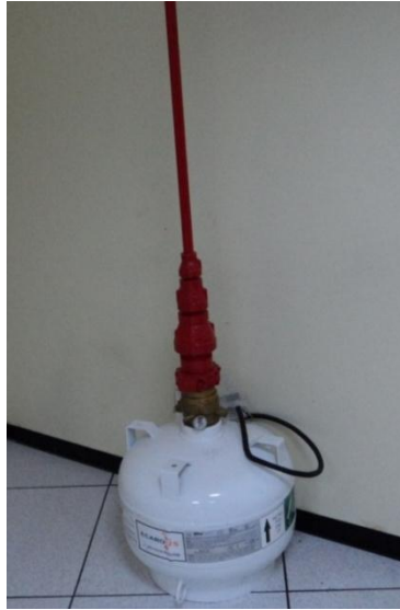
Figura N° 6.45: Cilindro de gas ECARO 25 Fuente: Investigación de campo
