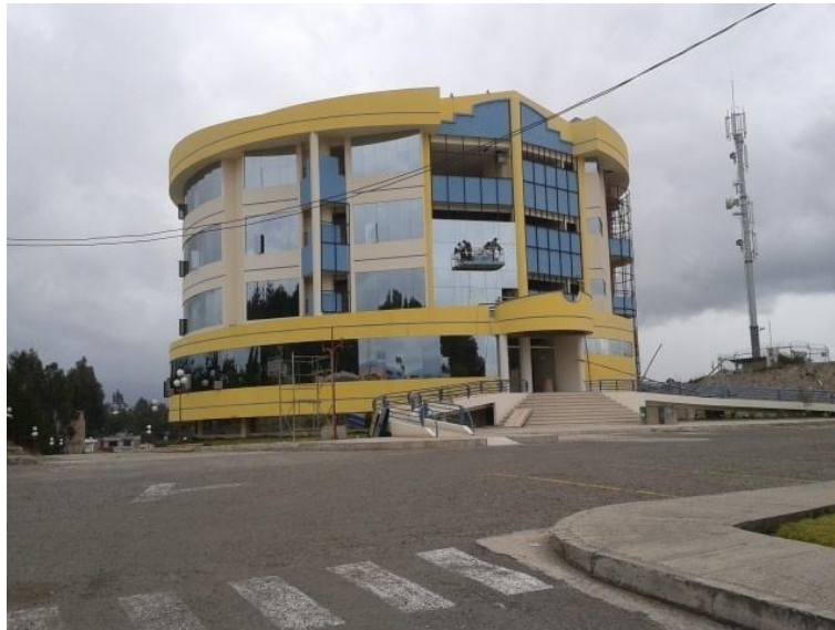
Figura A. Edificio donde se encuentra el Data Center Fuente: Investigación de campo
