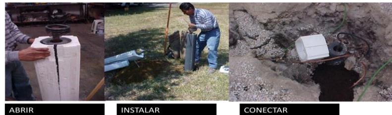
Figura N° 6.59: Pasos instalación puesta a tierra Fuente: www.parres.com.mx
