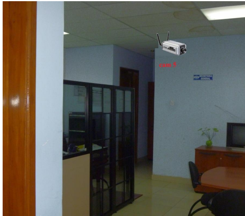
Figura N° 6.30. Cámara 5 localizada en la oficina de Asistente de Secretaria General
