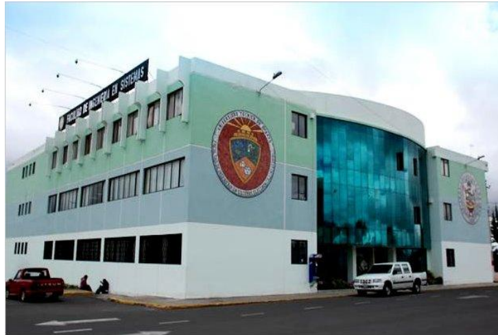
Figura N° 2.29. Edificio principal de la FISEI Elaborado por: La Investigadora
