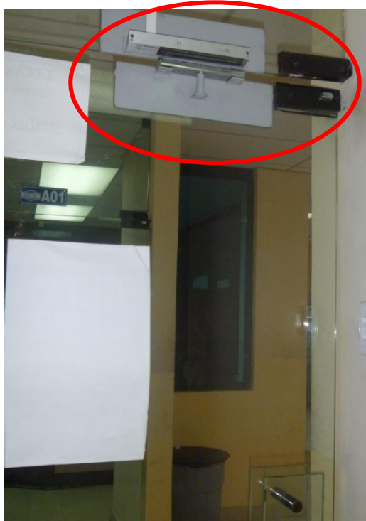
Figura N° 4.14. Electrocerradura de la puerta principal del área administrativa Elaborado por: La Investigadora
