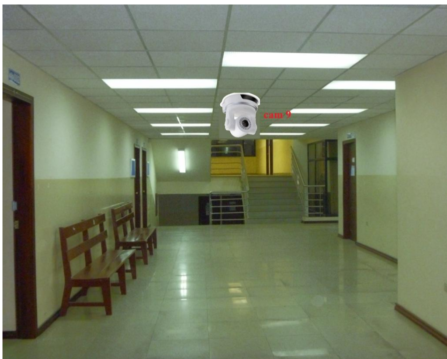
Figura N° 6.32. Cámara 9 ubicada en la primera planta del nuevo edificio Elaborado por: La Investigadora
