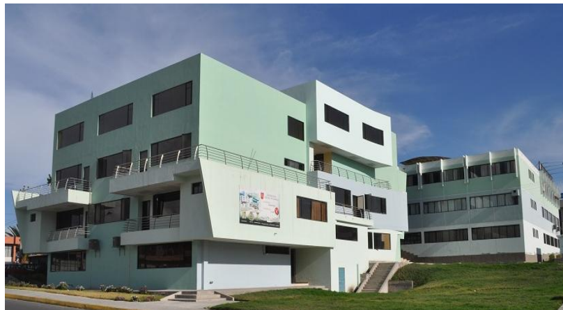
Figura N° 2.30. Edificio secundario de la FISEI Elaborado por: La Investigadora
