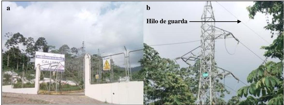
Figura 4.8.- S/E Caluma (a). Hilo de guarda tipo OPGW 20B40Z (b). Elaborado por: El Investigador.
