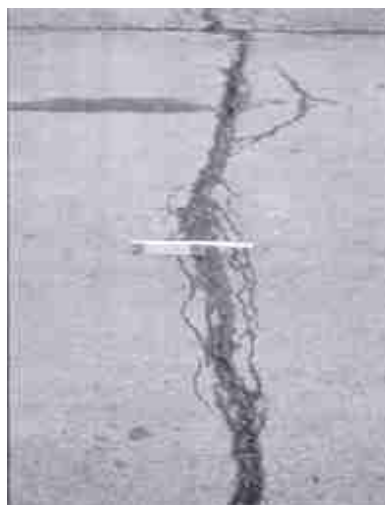
FOTO No. 2.24.- Falla Fisuramiento de Reflexión – Severidad Alta
