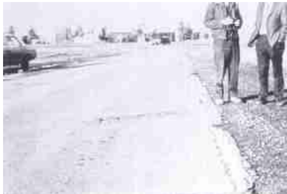
FOTO No. 2.12.- Falla Desnivel Localizado – Severidad Alta
