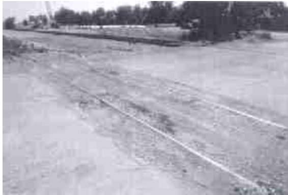
FOTO No. 2.41.- Falla Surco de Huella – Severidad Baja
