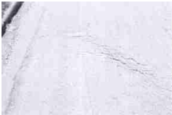
FOTO No. 2.48.- Falla Fisuramiento de Resbalamiento – Severidad Media
