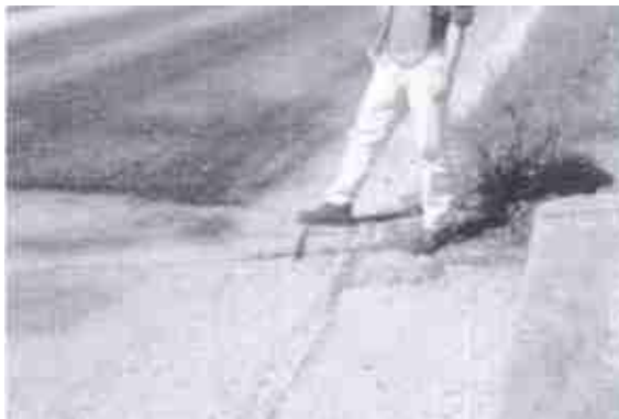
FOTO No. 2.45.- Falla Desplazamiento – Severidad Media
