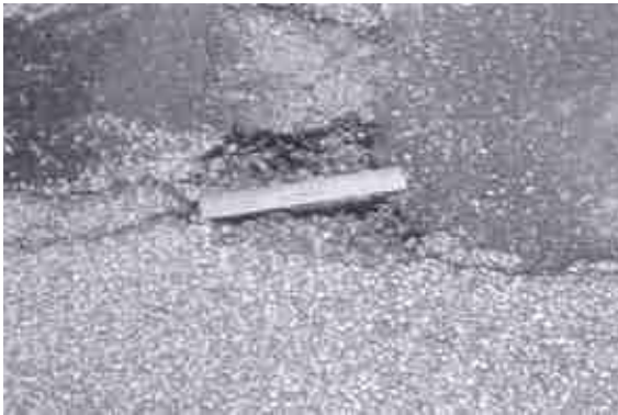
FOTO No. 2.36.- Falla Bache – Severidad Media
