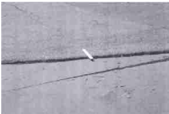
FOTO No. 2.45.- Falla Desplazamiento – Severidad Media
