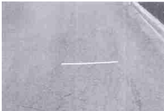
FOTO No. 2.3.- Falla Piel de Cocodrilo – Severidad Alta
