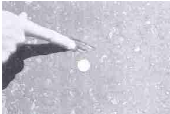
FOTO No. 2.6.- Falla Exudación – Severidad Alta
