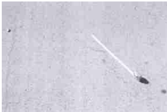
FOTO No. 2.48.- Falla Fisuramiento de Resbalamiento – Severidad Media
