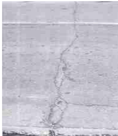
FOTO No. 2.24.- Falla Fisuramiento de Reflexión – Severidad Alta
