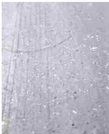
FOTO No. 2.6.- Falla Exudación – Severidad Alta
