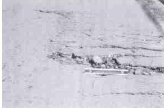
FOTO No. 2.50.- Falla Hinchamiento – Severidad Baja
