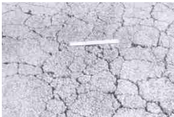
FOTO No. 2.3.- Falla Piel de Cocodrilo – Severidad Alta
