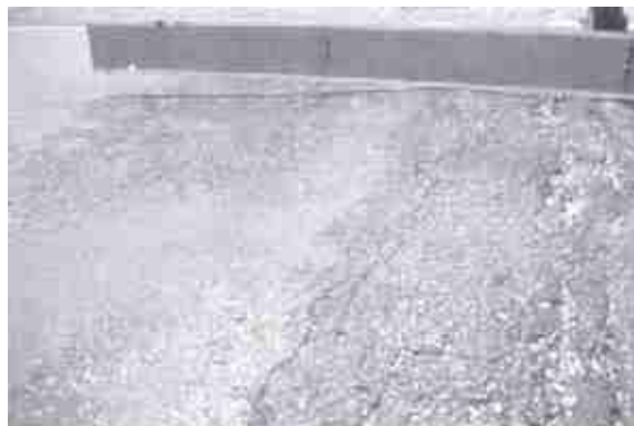
FOTO No. 2.12.- Falla Desnivel Localizado – Severidad Alta
