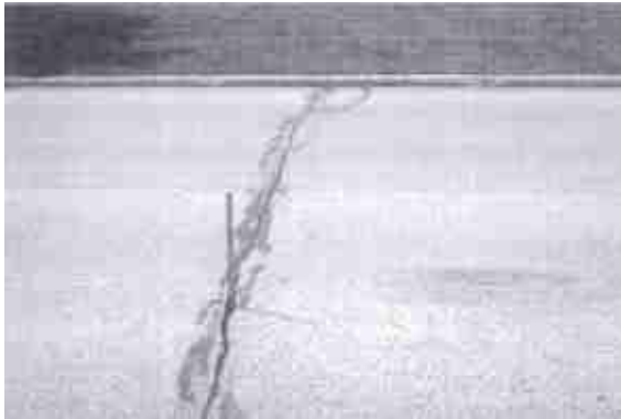
FOTO No. 2.29.- Falla Fisuramiento Longitudinal y/o Transversal – Severidad Media
