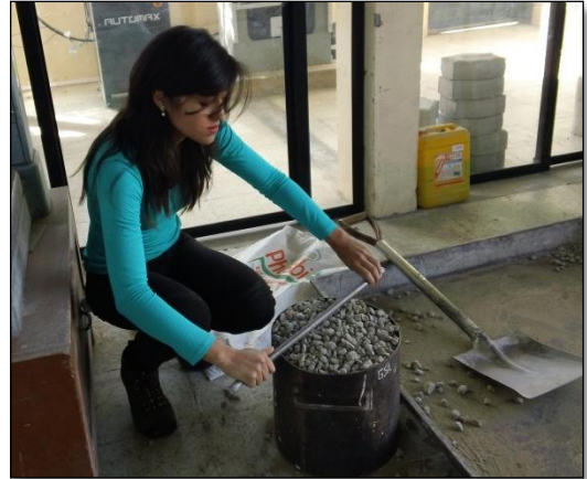
Imagen 37. Enrasado de material Fuente propia
