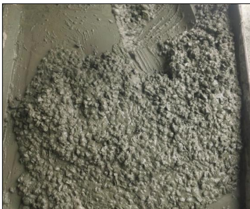
Imagen 26. Mezcla del material Fuente propia
