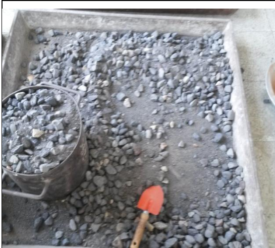
Mezcla de Agregados
