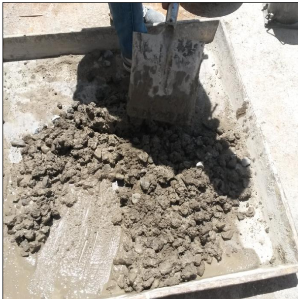
Gráfico N°14. Mezclado del hormigón
