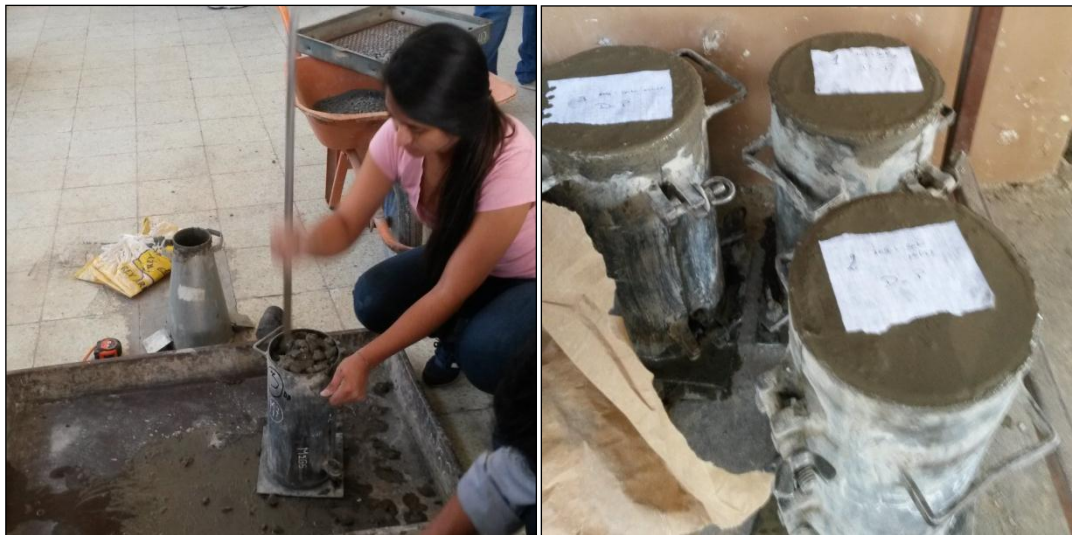
Gráfico N°16. Llenado de Moldes de Hormigón
