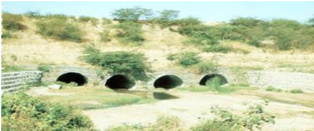
Fotografía N°3.- Alcantarillas en Bóveda
