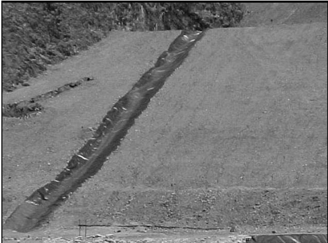
**Figura 26 Bajante de aguas superficiales en talud de suelos arenosos**
