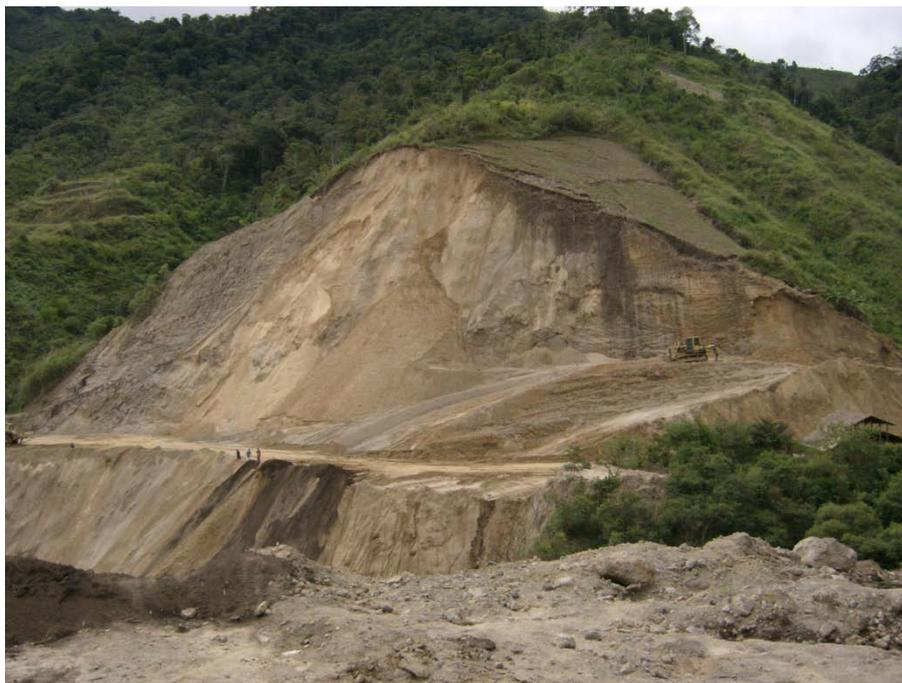
**Ilustración 1. Progreso del Deslizamiento de talud Absc. Km. 9+600 Lado Derecho (Fase Inicial)**
