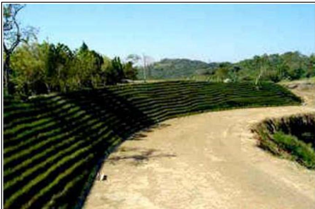
**Figura 2** Vía con taludes estabilizados con vegetación
