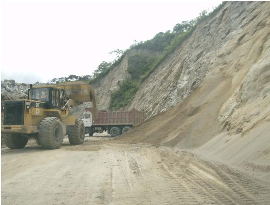
**Ilustración 4. Progreso del Deslizamiento de talud Absc. Km. 11+440 Lado Derecho (Fase Actual)**
