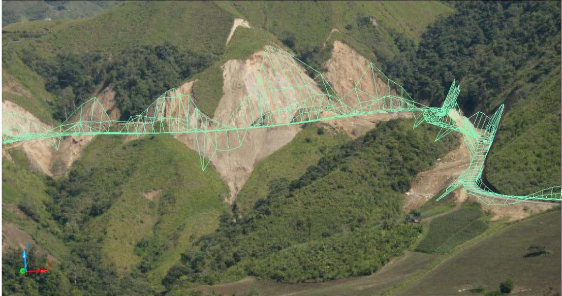
**Ilustración 9 Derrumbes en Km 16+340 a 16+560**
