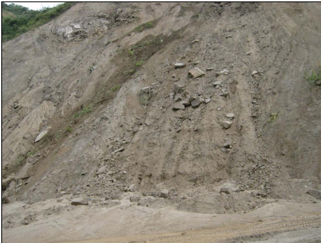
**Figura 1** Deslizamiento de suelo desde talud de la vía Km 10+400
