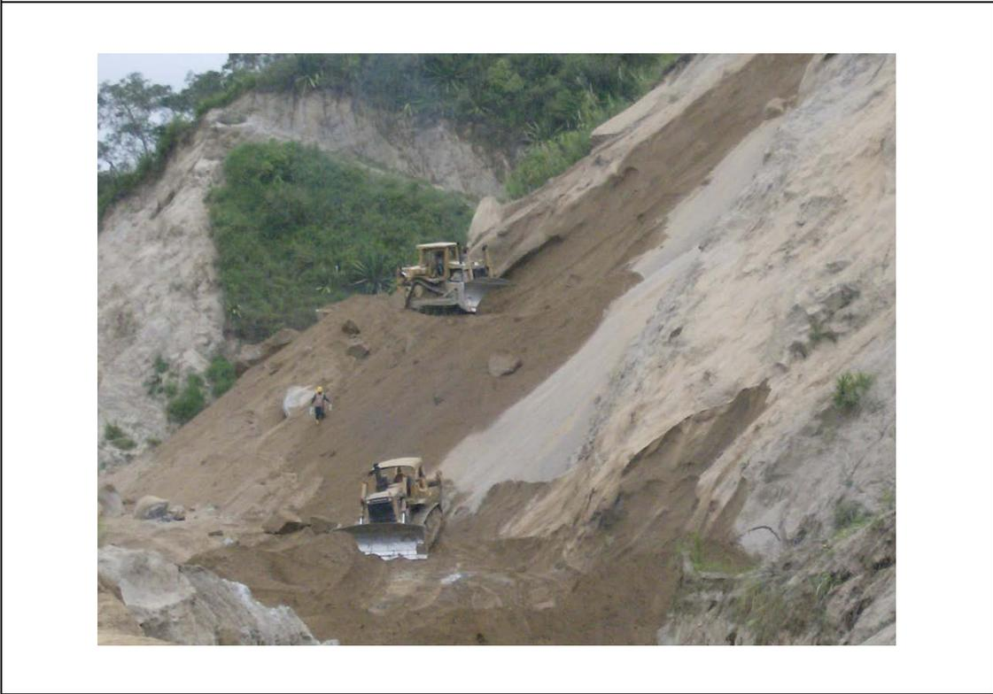
**Ilustración 3. Progreso del Deslizamiento de talud Absc. Km. 11+440 Lado Derecho (Fase Inicial)**
