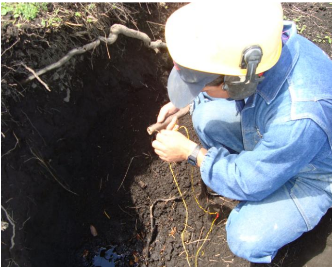
Anclaje del cordón detonante
