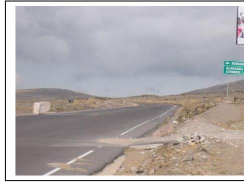
63+300.- ENLACE VÍA A RIOBAMBA: VÍA EN BUEN ESTADO (RECAPEADO)
