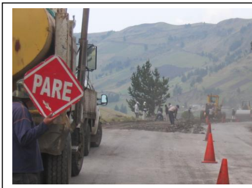
72+200.- REPARACIÓN CARPETA: BASE RECICLADA Y RECAPEO
