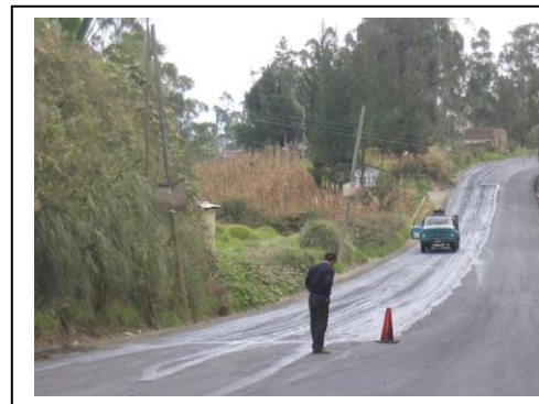
105+100.- MANTENIMIENTO Y REHABILITACIÓN
