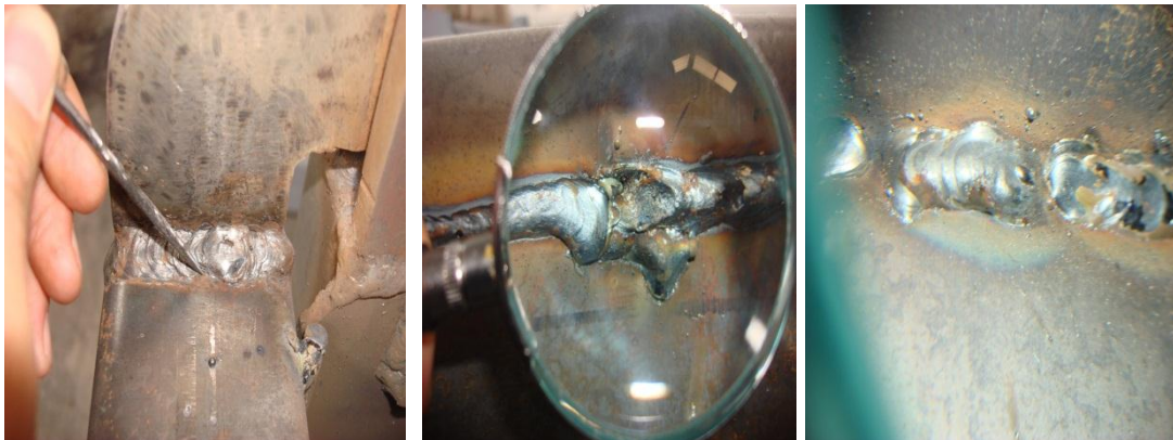
Figura 6.3. Proceso de inspección visual en cordones de soldadura. FUENTE: Planta industrial I.M.ESCO.
