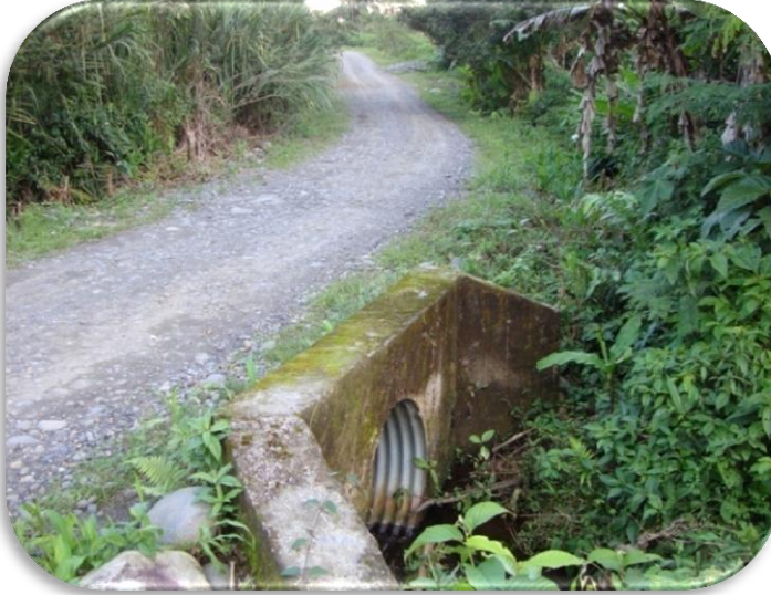
Alcantarilla existente (ármico \varnothing=1,20\text{m} )
