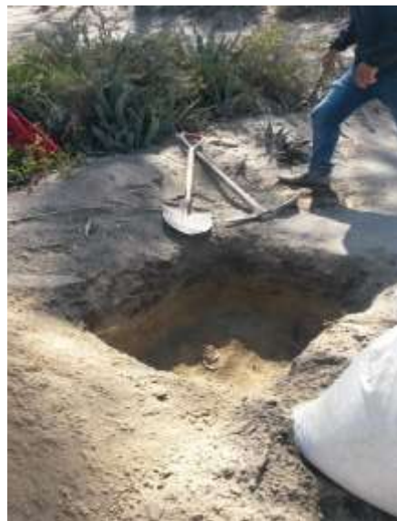
Calicata a cielo abierto
