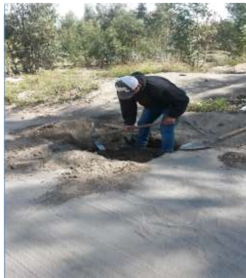
Calicata a cielo abierto
