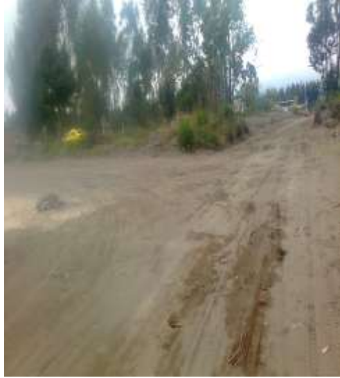
Vía en estudio, km 1 + 000
