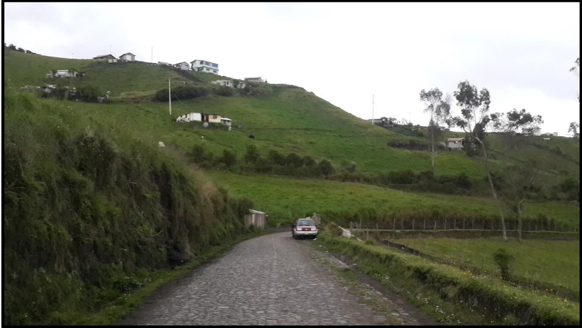
IMAGEN 7.- POBLACIÓN Y PARTE DE LA VÍA EMPEDRADA
