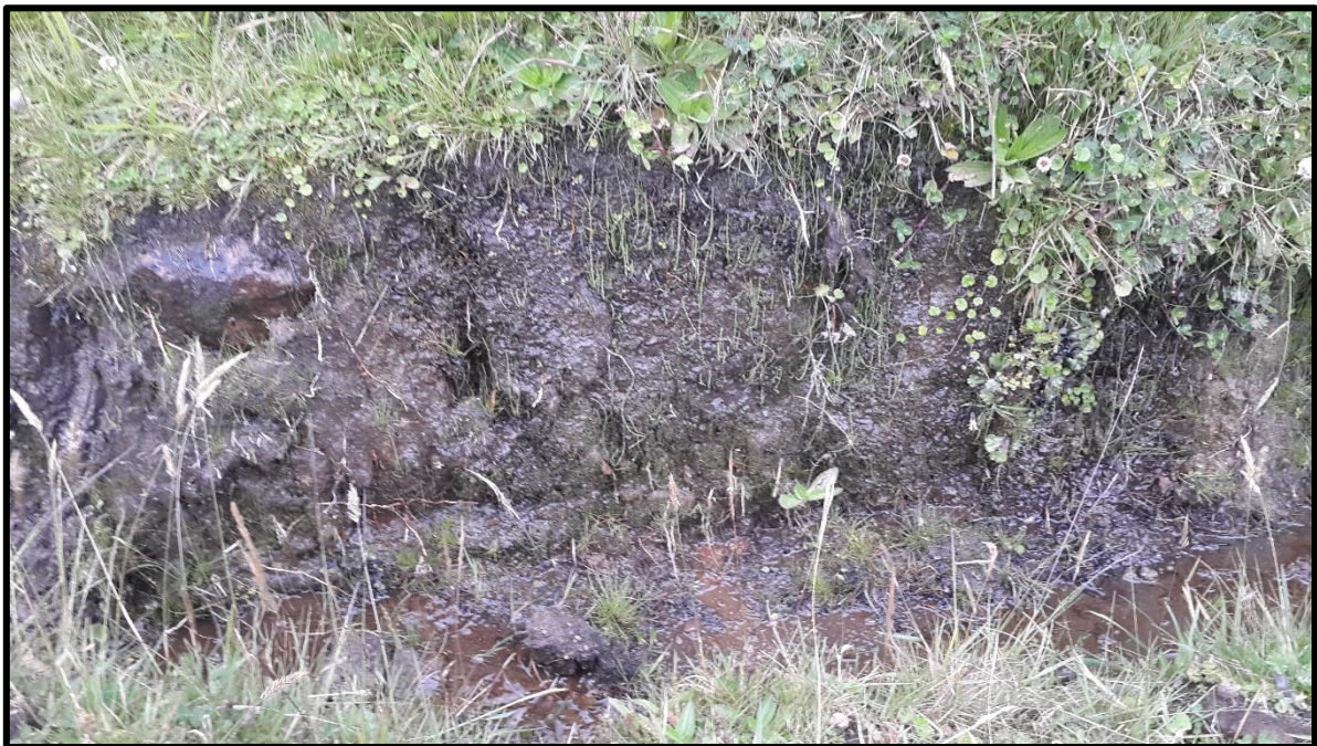
IMAGEN 6.- NIVEL FREÁTICO ALTO
