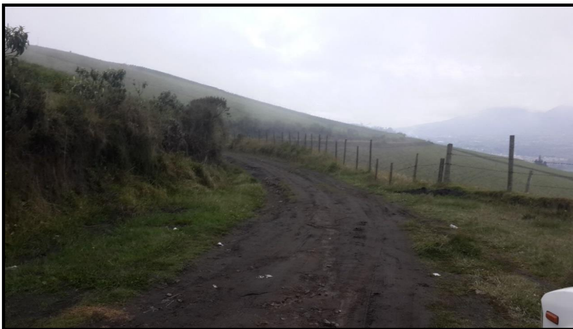
IMAGEN 1.- VÍA EN ESTUDIO SIN NINGÚN TIPO DE MEJORAMIENTO PARA TRANSITARLA
