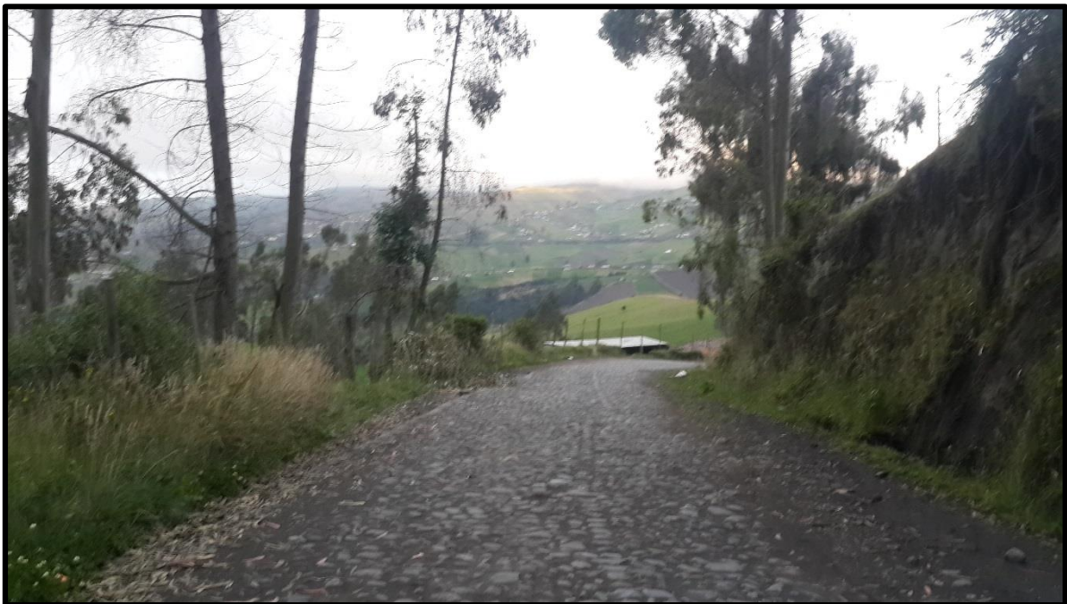
IMAGEN 8.- EMPEDRADO EN MAL ESTADO
