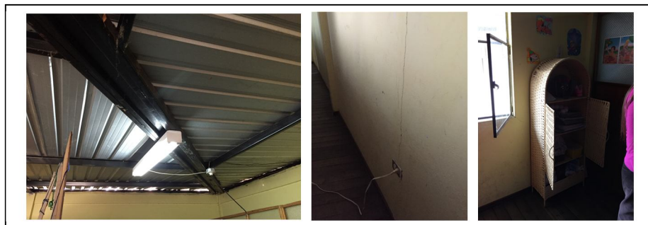
Gráfico N°66: Iglesia “Dios con Nosotros” (área de enseñanza bíblica, iluminación y ventilación) Elaborado por: VASCO, A. 2015
