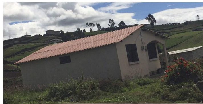
VIVIENDA ESTADO ACTUAL
