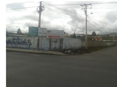
1.- Vista cerramiento frontal de la propiedad en estudio
